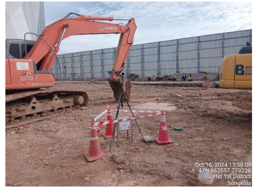
รูปที่ 40 ติดตั้งเครื่องตรวจวัดคุณภาพระดับเสียงโดยทั่วไป และความสั่นสะเทือน
