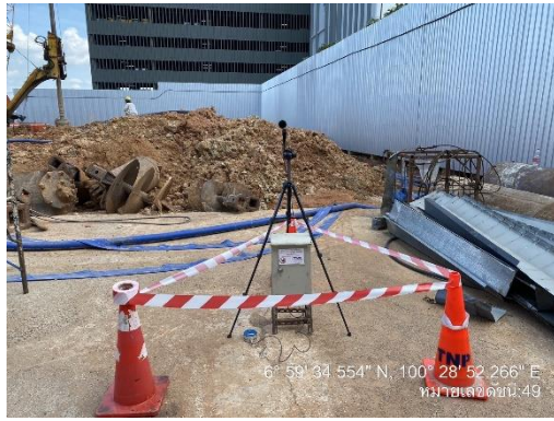
รูปที่ 40 ติดตั้งเครื่องตรวจวัดคุณภาพระดับเสียงโดยทั่วไป และความสั่นสะเทือน
