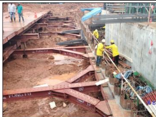
รูปที่ 17 ระบบป้องกันดินพัง (Sheet Pile)
