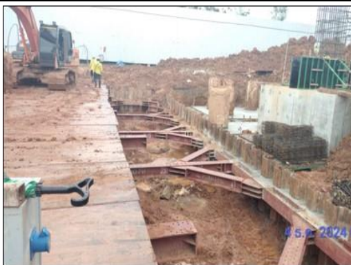
รูปที่ 17 ระบบป้องกันดินพัง (Sheet Pile)
