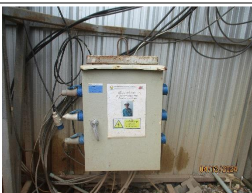
รูปที่ 22 ตู้ไฟฟ้าชั่วคราว และช่างไฟฟ้าผู้รับผิดชอบ
